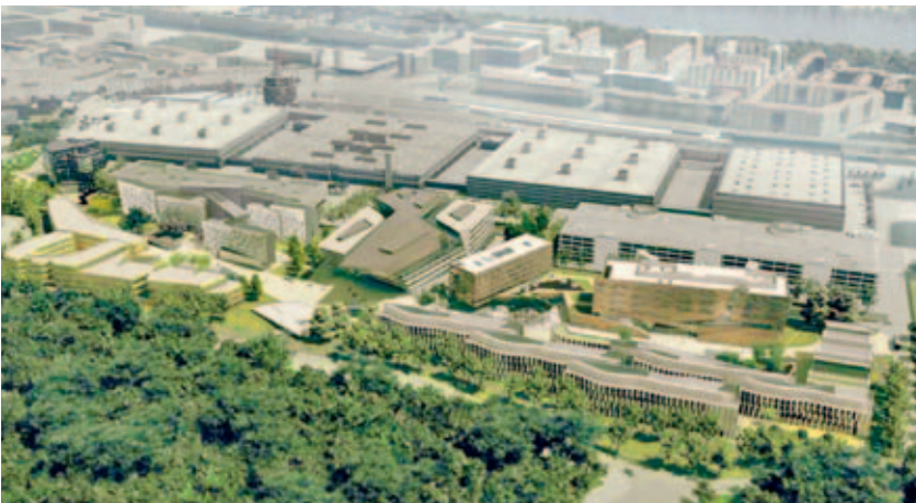
Bis 2013 soll die neue Wirtschaftsuniversität Campus WU mit architektonischer Vielfalt von Zaha Hadid Architects, Atelier Hitoshi Abe, Estudio Carme Pinos, NO.MAD Arquitectos/Eduardo Arroyo sowie CRAB-studio Architects/Peter Cook fertiggestellt sein. Das Ingenieurbüro Vasko + Partner fungiert als Generalkonsulent. Auftraggeber ist die von WU und BIG gemeinsam gegründete Projektgesellschaft Wirtschaftsuniversität Wien Neu. Der Baubeginn erfolgte mit Ende 2009. Die Gesamtprojektkosten betragen 480 Millionen Euro, die Baukosten machen rund 300 Millionen aus.
