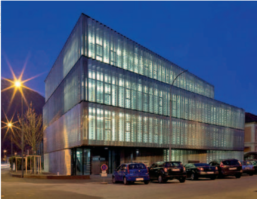
Die Asfinag versucht, sich durch bewusste Förderung von Baukultur zu profilieren (Verwaltungsgebäude Innsbruck, geplant von Peter Lorenz)
