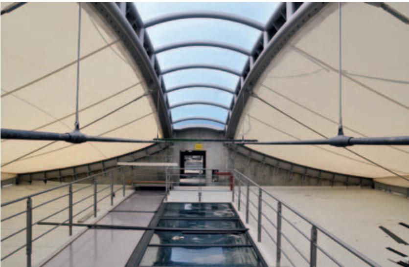
Eingespannt werden die mehrschaligen, transluzenten Textilien zwischen eine Stahlkonstruktion.
