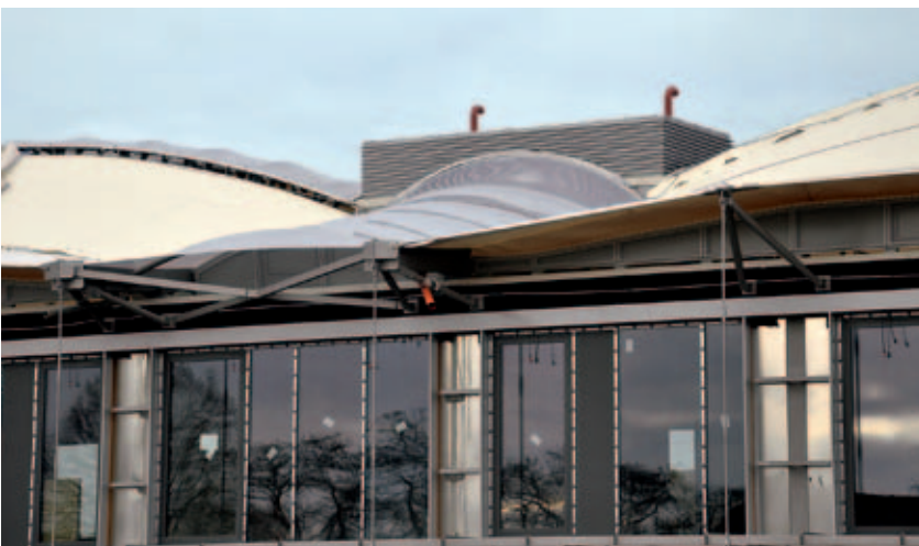
Das EEC in Bau.
