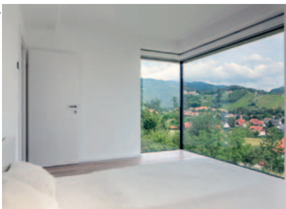
EFH Mayer: Moderne Ganzglassysteme wie VISIONLINE von Gaulhofer erreichen ähnliche Dämmwerte wie eine Außenwand.
