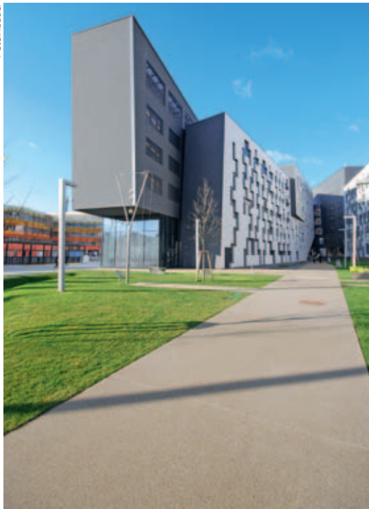
Teile der Außenbeläge am Campus wurden mit einem wasserdurchlässigen TerraWay-Belag gestaltet.
