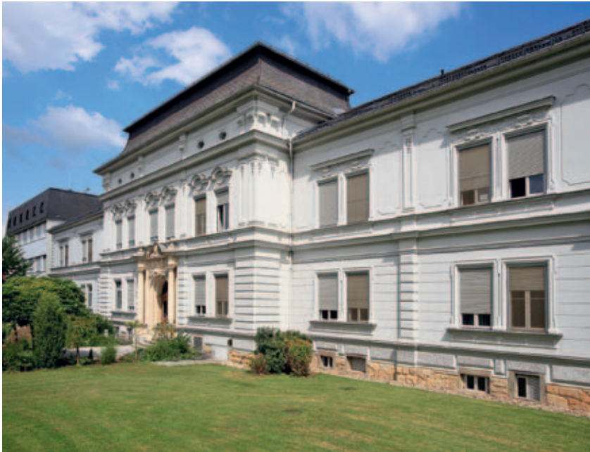
LKH Radkersburg: Gebäudeteile sind nun barrierefrei miteinander verbunden. Mit Bauteilaktivierung, Solarthermie und Strahlungswärme wird Energie eingespart.
