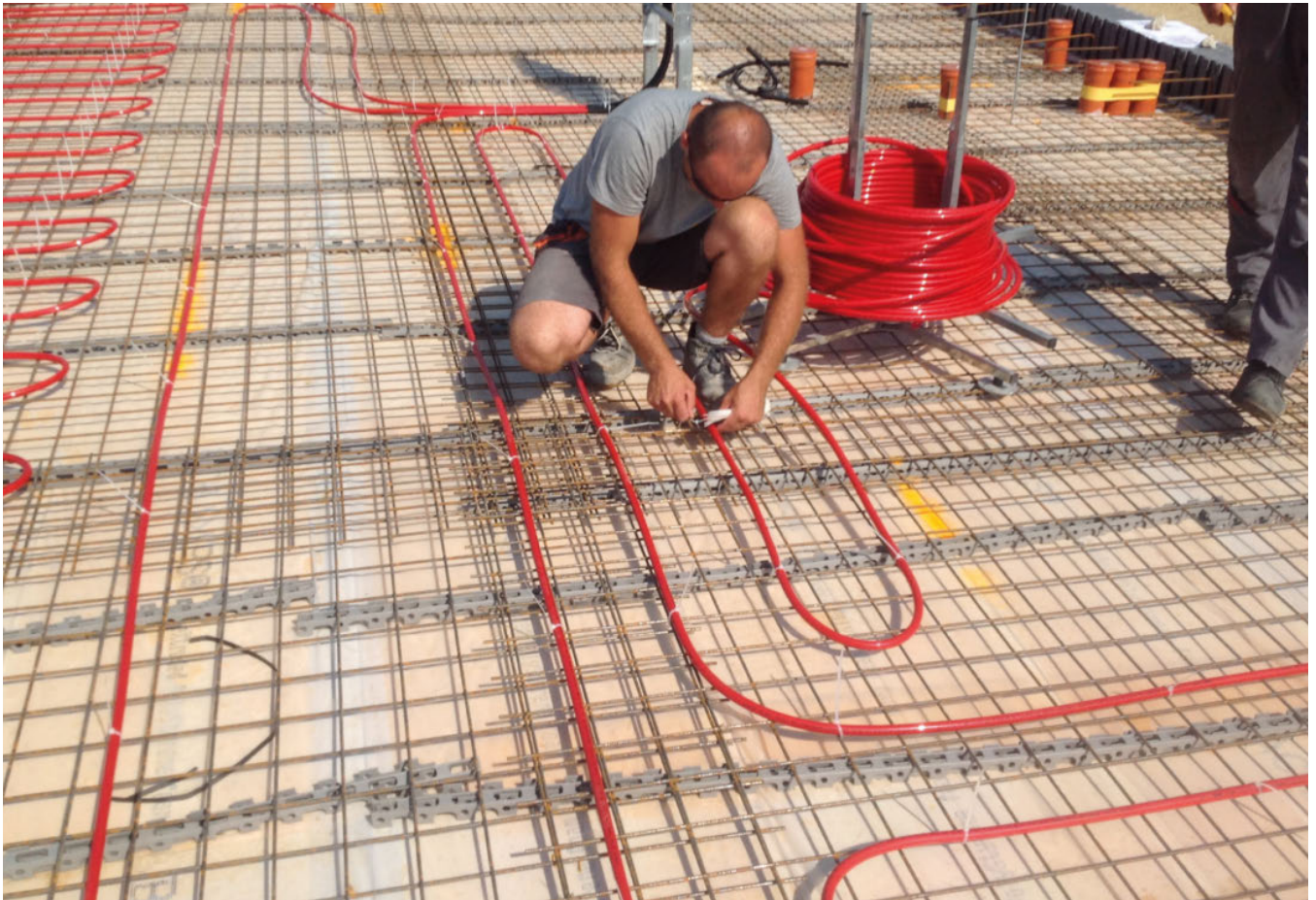
Die Rohrleitungen werden mittels Kabelbindern an der bestehenden Bewehrung befestigt.
