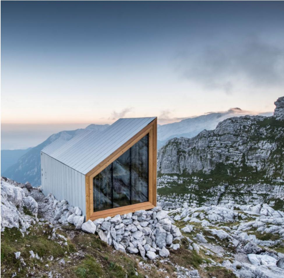
Die Fassaden des alpinen Biwaks sind mit 13 mm dünnen Glasfaserplatten verkleidet.
