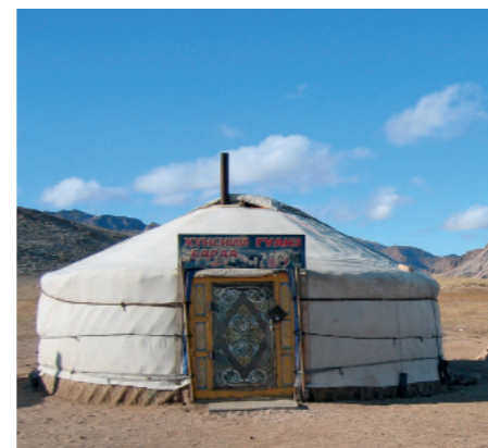
Fassade in der ursprünglichen Wortbedeutung: Mongolische Jurte mit Hülle aus Segeltuch.
