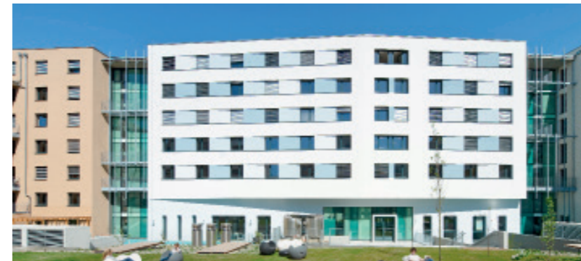
Das als Passivhaus zertifizierte Studentenwohnheim ist von einer luftdichten Wärmedämmung umhüllt.
