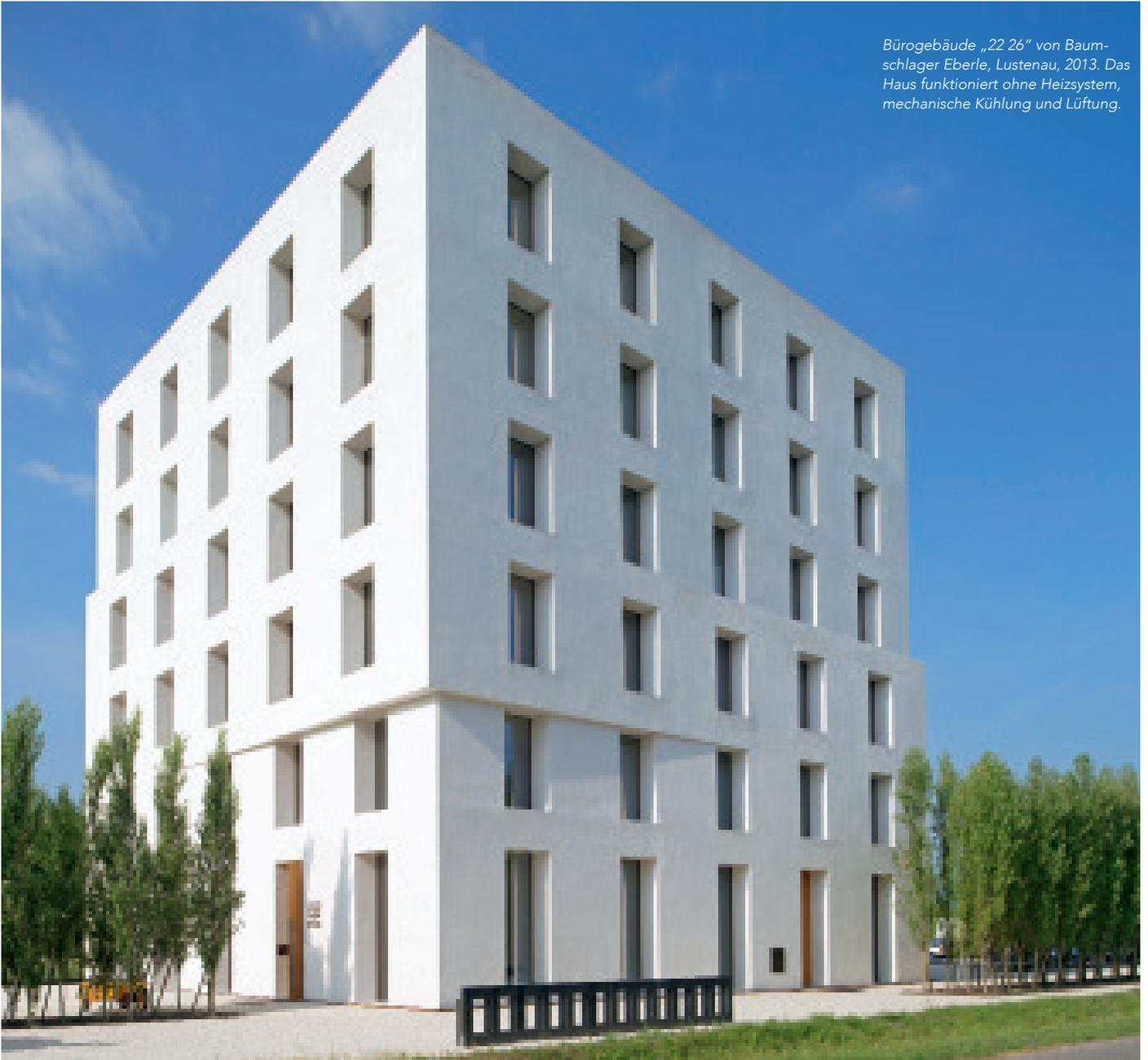
Bürogebäude „22 26“ von Baumschlagler Eberle, Lustenau, 2013. Das Haus funktioniert ohne Heizsystem, mechanische Kühlung und Lüftung.
