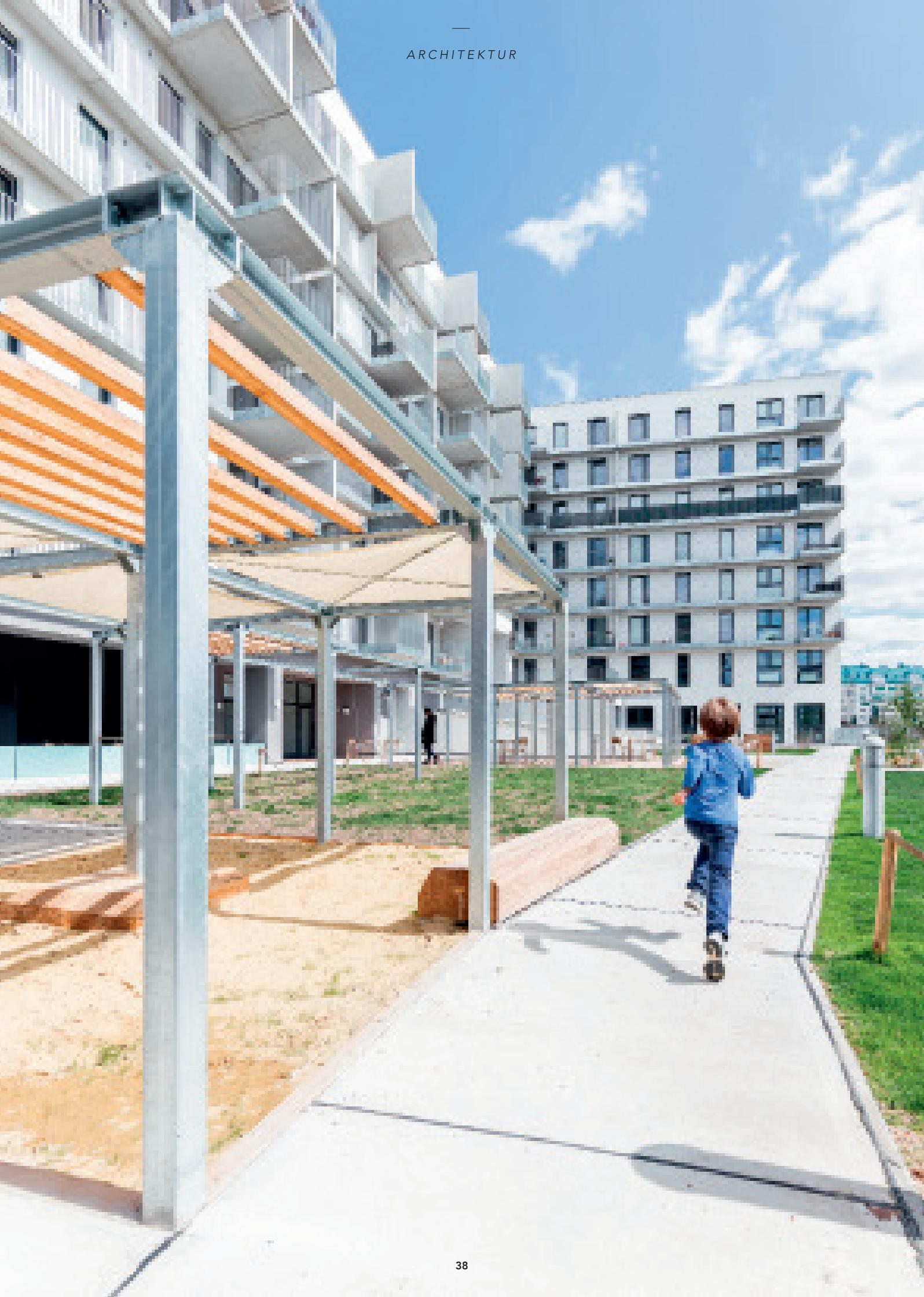
Ein geschosshohes Gerüst aus Stahlformrohren überspannt den Hof.
