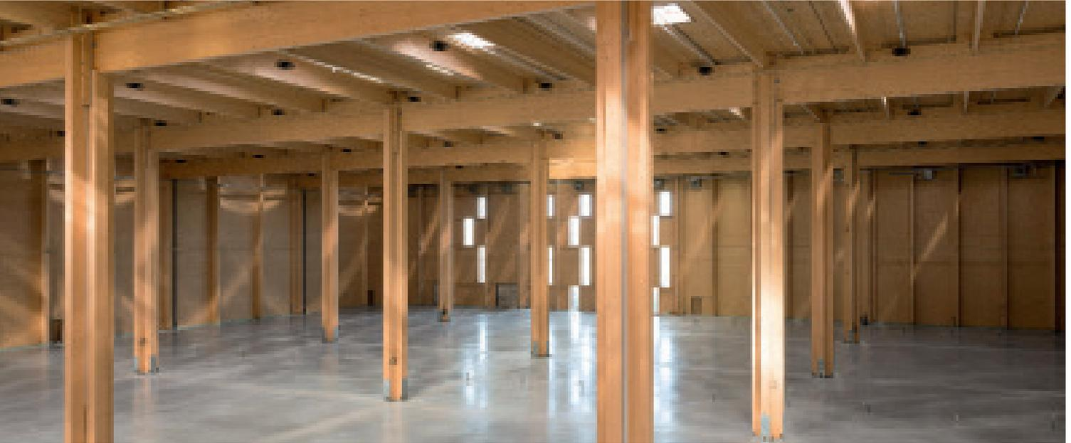
Die längsten Stützen haben eine Höhe von 16,3 Meter, Dach- und Wandelemente sind ebenfalls aus Holz.
