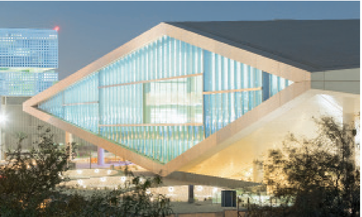
Die Fassade aus Wellglas dämpft das einfallende Sonnenlicht.
