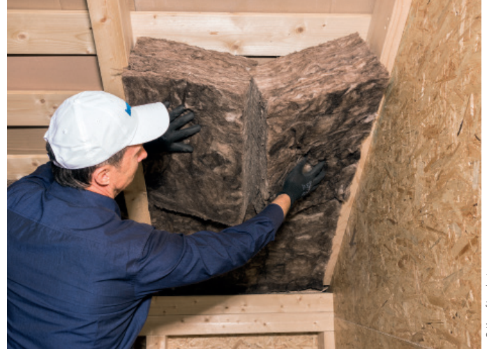
Nicht plattenförmige Dämmstoffe aus erneuerbaren Rohstoffen mit genügend Restbiomasse sind im Vorteil.
