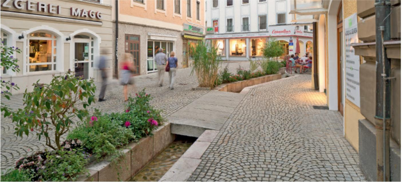
Fußgängerzone nahe Salzburg: Wasserführung aus Kalkstein in Kombination mit massiven Granitplatten und Kleinsteinpflaster.
