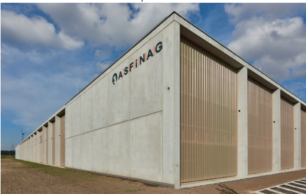
Die massive Betonstruktur wird von Feldern mit Säulen und Trapezblechfassade unterbrochen.
