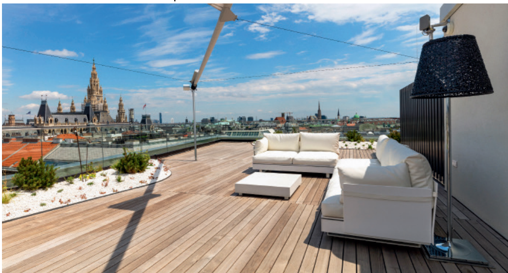
Dachterrasse mit Kühlanlage und Photovoltaikanlage
