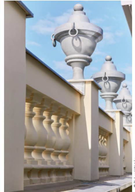
Denkmalpflegerisch wichtiges Detail der Sanierung: Attikabalustrade aus St. Margarethener Kalksandstein
