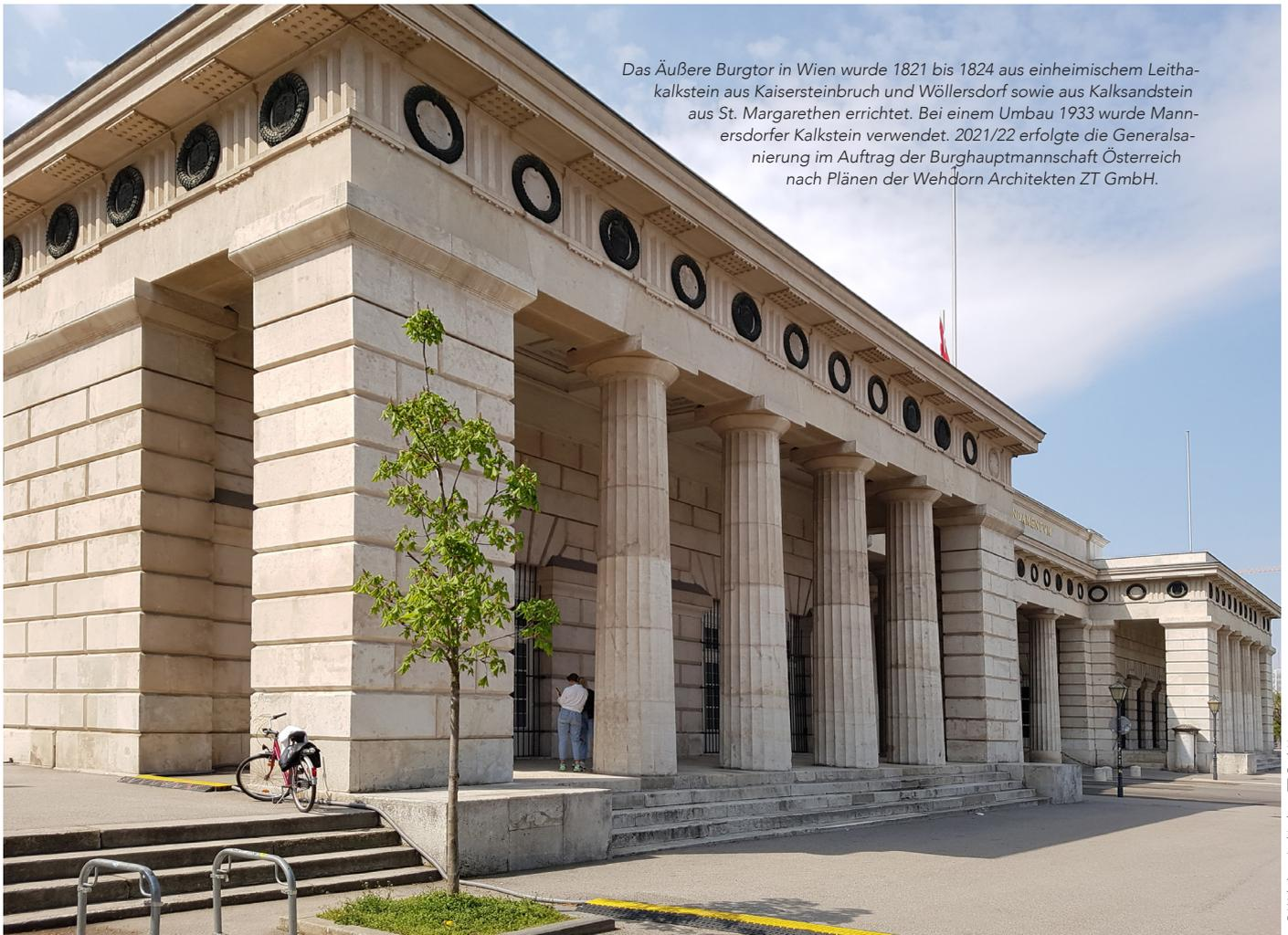
Das Äußere Burgtor in Wien wurde 1821 bis 1824 aus einheimischem Leithakalkstein aus Kaisersteinbruch und Wöllersdorf sowie aus Kalksandstein aus St. Margarethen errichtet. Bei einem Umbau 1933 wurde Mannsdorfer Kalkstein verwendet. 2021/22 erfolgte die Generalsanierung im Auftrag der Burghauptmannschaft Österreich nach Plänen der Wehdorn Architekten ZT GmbH.
