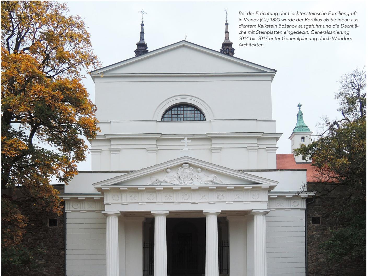
Bei der Errichtung der Liechtensteinsche Familiengruft in Vranov (CZ) 1820 wurde der Portikus als Steinbau aus dichtem Kalkstein Božanov ausgeführt und die Dachfläche mit Steinplatten eingedeckt. Generalsanierung 2014 bis 2017 unter Generalplanung durch Wehdorn Architekten.
