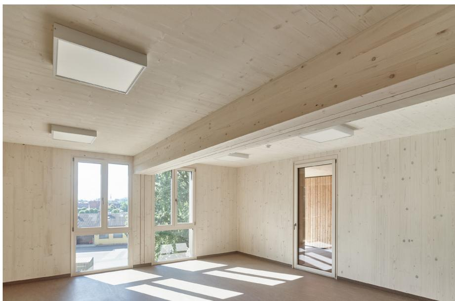
**„DAS VON UNS ENTWICKELTE SYSTEM IN RAUMZELLENBAUWEISE SOLL NACH EVALUIERUNG ALS STANDARD FÜR WEITERE UNTERKUNFTSBAUTEN DIENEN. DIE MASSIVHOLZBAUWEISE IST DAFÜR SEHR GUT GEEIGNET – SIE IST ROBUST UND KANN WEITERVERWENDET WERDEN.“**
