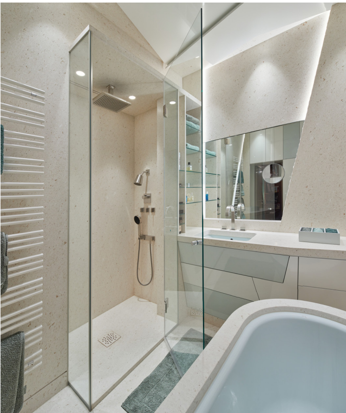
Die konischen Bogenstücke der Wannabekleidung sind steintechnisch außergewöhnlich aufwendig.
