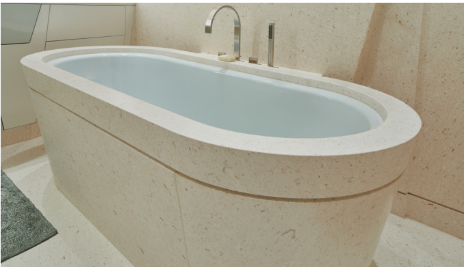
Die konischen Bogenstücke der Wannabekleidung sind steintechnisch außergewöhnlich aufwendig.
