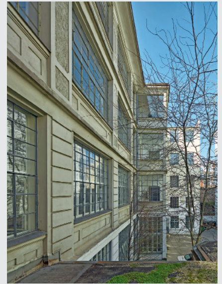
Eisenbetongebäude im 7. Bezirk in Wien – die Langlebigkeit einer Betonfassade wird bei dem 120 Jahre alten Gebäude unter Beweis gestellt.
