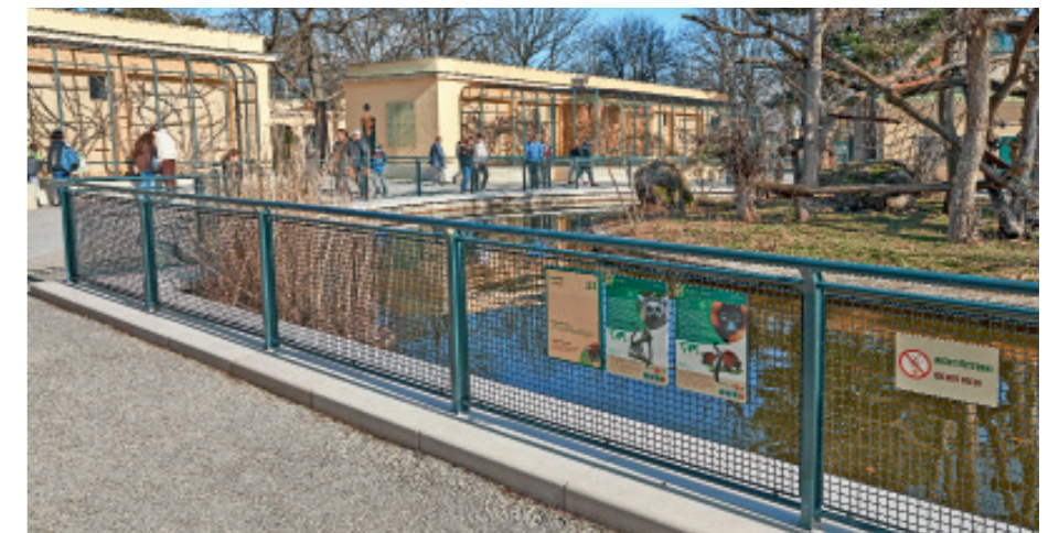
Das Geländer blieb bei der Baumaßnahme in situ erhalten.
