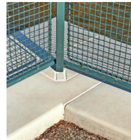
Die Ausnehmungen für das Geländer wurden mit einer Abrasivstrahl-Schneidanlage ausgeschnitten.
