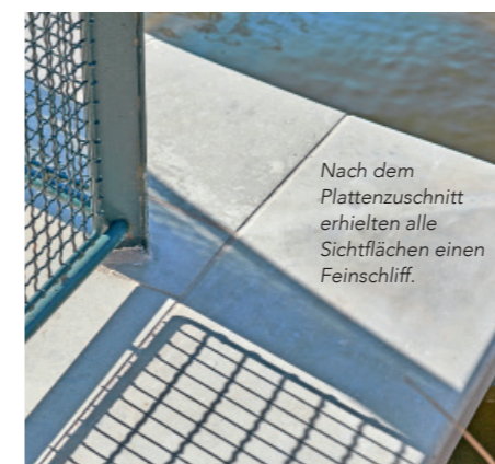
Die Ausnehmungen für das Geländer wurden mit einer Abrasivstrahl-Schneidanlage ausgeschnitten.
