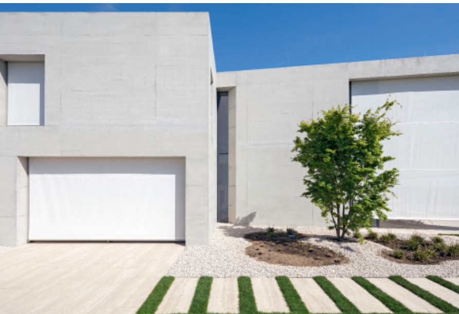
Für die Garage wurde entlang der ostseitigen Grundstücksgrenze ein selbstständiger Baukörper errichtet.
