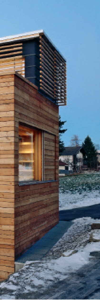
Das Doppelhaus in Sistrans wurde als modulares Haus mit kreuzverleimtem Holz entwickelt. Aufgrund der hohen Dämmstärke und der Bauweise erreicht das Gebäude eine Energiekennzahl von weniger als 15 kWh/m 2 a und erfüllt damit Passivhausstandard.
