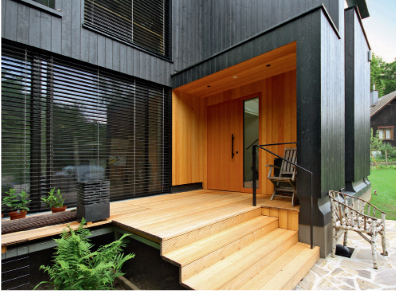
Sämtliche Bleche, Fensterrahmen und weitere Elemente an der Außenhaut wurden farblich an die Holzbretter angepasst.
