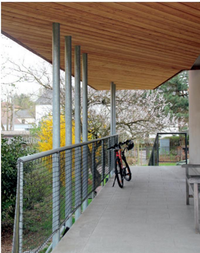
Das Zimmer lagert auf fünf Stahlstützen.
