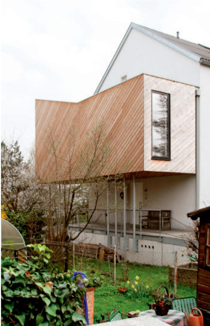
Der Zubau besteht aus Holz mit einer Verkleidung aus diagonal montierten Lärchenholzlatten.
