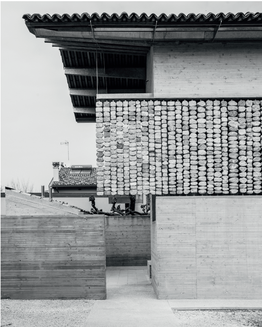
Die Betonkonstruktion dient als Verstärkung der Steinstrukturen in einer erdbebengefährdeten Zone.
