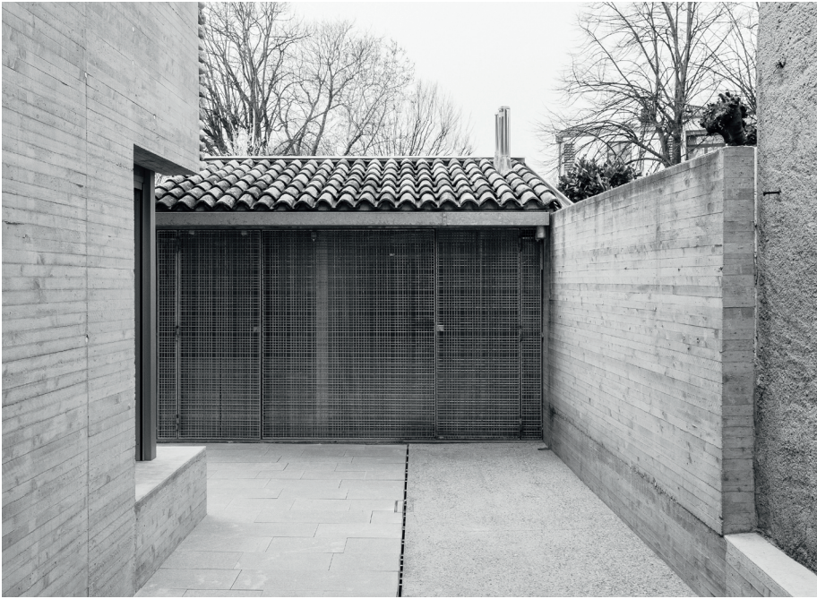
Die Betonkonstruktion dient als Verstärkung der Steinstrukturen in einer erdbebengefährdeten Zone.
