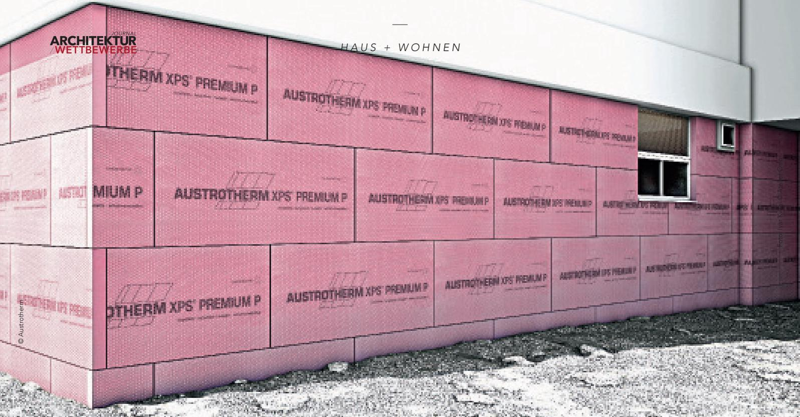
Platten aus XPS eignen sich besonders für die Dämmung im Sockelbereich.
