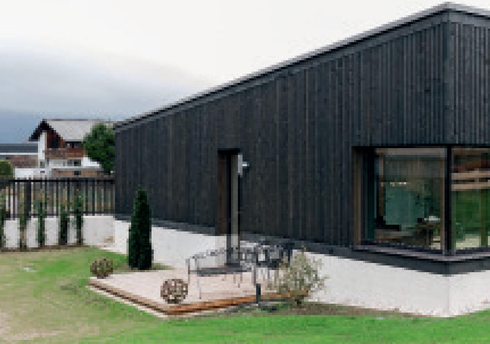
*Das Haus besteht aus vorgefertigten Holz-Riegel-Elementen auf einem Betonsockel.*
